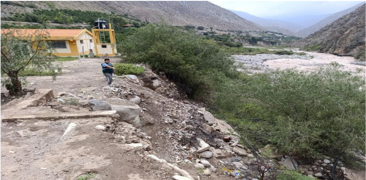
FOTOGRAFIA N°02: TRAMO CRÍTICO EN LA MARGEN IZQUIERDA DEL RIO HAUYTARA, ENCONTRANDOSE SOCAVADO..
