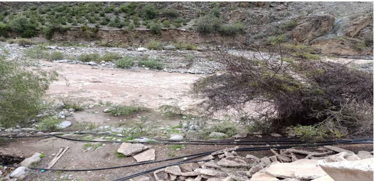
FOTOGRAFIA N°03: TRAMO CRÍTICO EN EL RIO HUAYTARA, ENCONTRANDOSE SOCAVADO Y AFECTANDO CANLES DE RIEGO.
